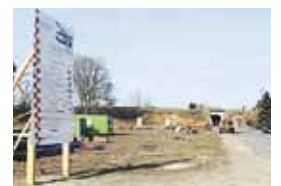
Die Arbeiten im Bereich der künftigen Endhaltestelle Bf-Mahndorf haben bereits begonnen.
